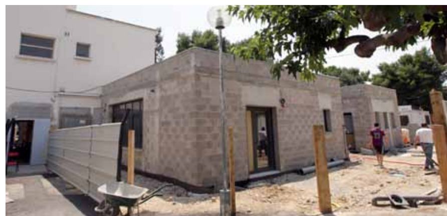
Construction d'un restaurant scolaire à Alembert.
