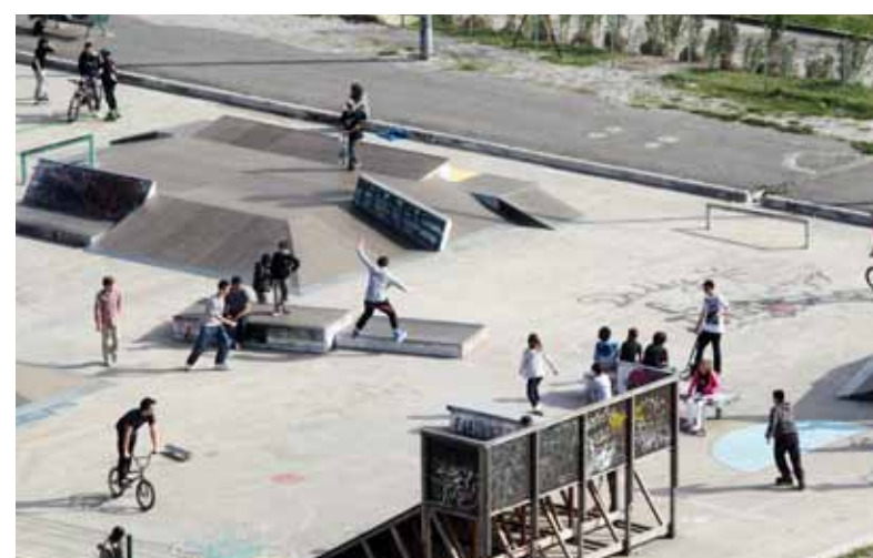
Le skatepark du Moulin à Vent.
